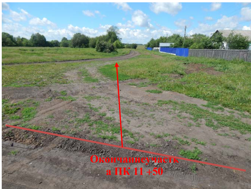
Фото 2.1. Местоположение окончания обследуемого участка автодороги ПК11+50 – примыкание к ул.Школьная (створ жилого дома №12 по ул.Школьная) с.Каргалеи Вадинский район Пензенской области;
